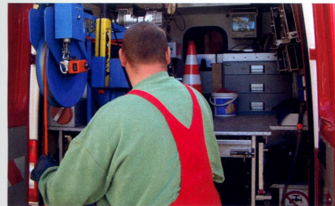
Die TV-Kamera wird in den Kanal eingebracht.
