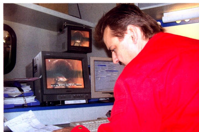
TV-Operator Jürgen Bay lokalisiert anhand der Entwässerungspläne den festgestellten Schaden.
